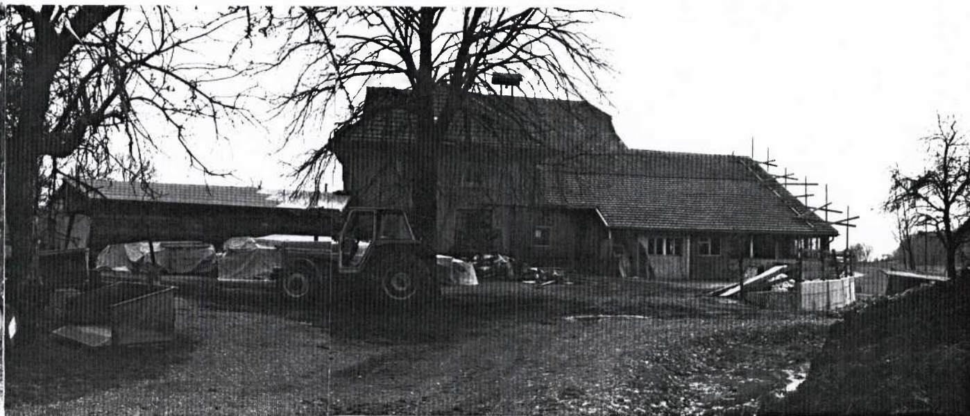
éviter l'entreposage de façon dispersée
